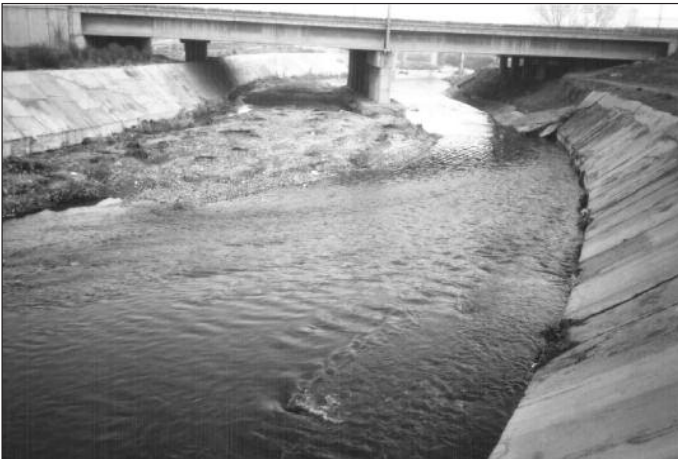
Fotografía 3. Canalización de las orillas del río Manzanares.
